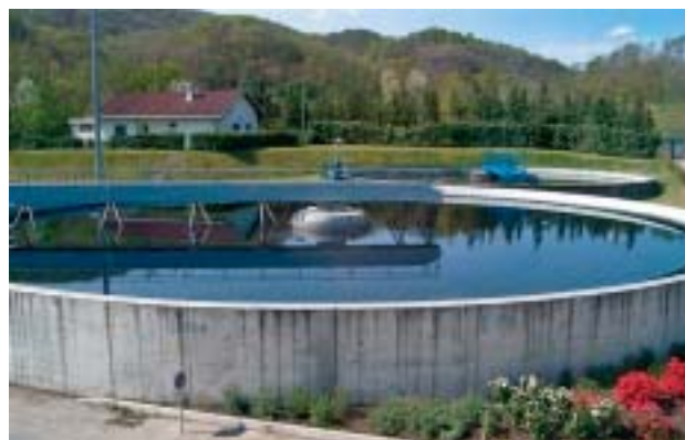
FIGURA 9: SEDIMENTAZIONE SECONDARIA
