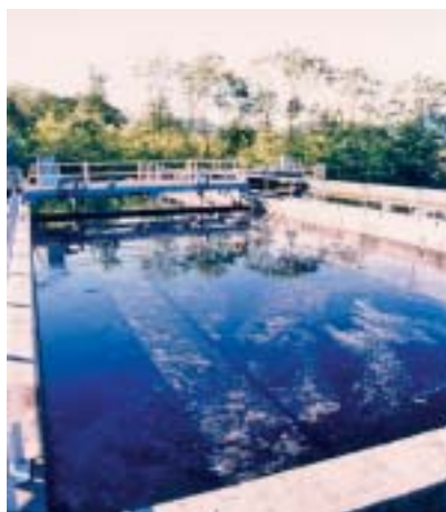
FIGURA 6: SEDIMENTATORE PRIMARIO
