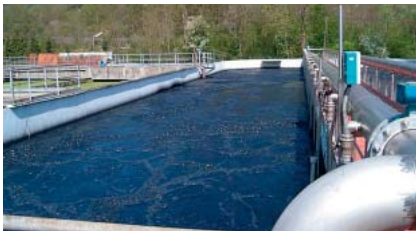
FIGURA 7: OSSIDAZIONE A BOLLE FINI (NITRIFICAZIONE)
