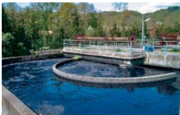
FIGURA 8: OSSIDAZIONE ROTORI MAMMUTH (NITRO-DENITRO)
